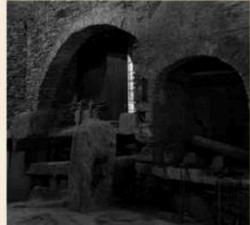
Il **forno di fusione** era alimentato con carbone di legna e portato in temperatura con l'aiuto di aria compressa. I prati che circondano la fucina ospitano le carbonaie, una è stata ricostruita poco più avanti e potete vedere come funzionava.
